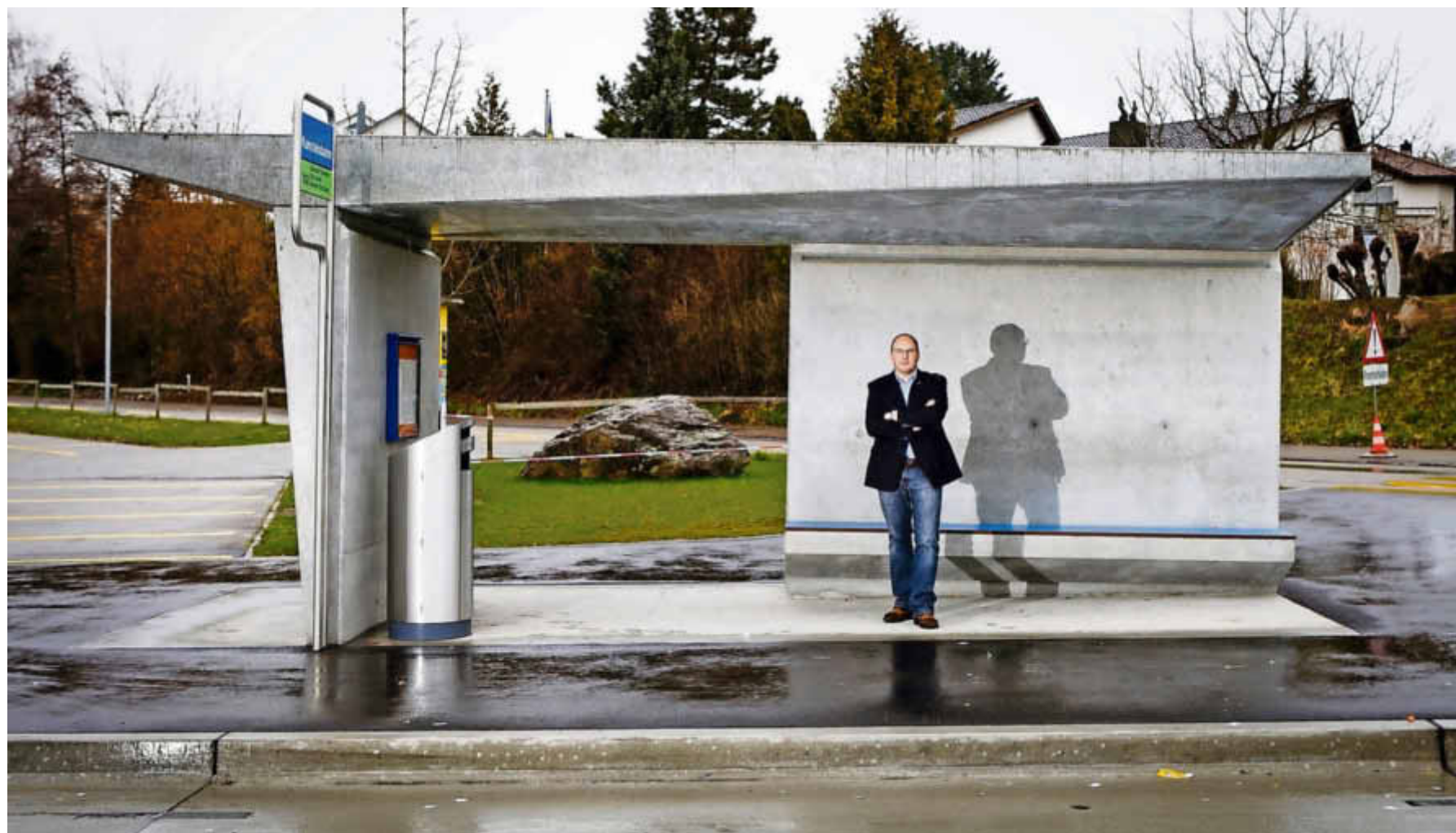
Weicht in einer konservativen Branche von der Norm ab: Bruno Inauen vor dem ersten mit Betonelementen gebauten Bushäuschen in Dübendorf. Bild: Nicolas Zorvi
