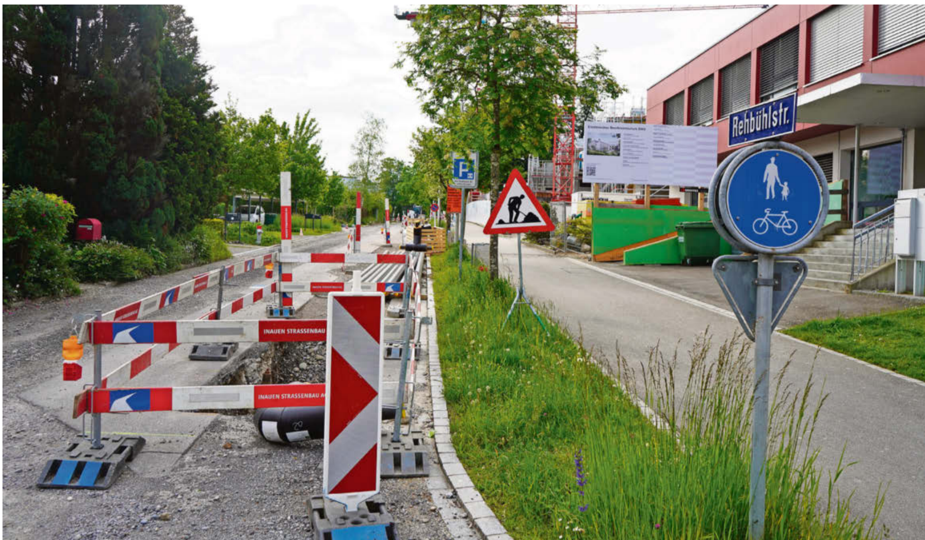
Die Rehbühlstrasse ist eine von vier Strassen in Uster, die derzeit saniert werden. Die neuen Randsteine stammen aus heimischer Produktion. Foto: Sandro Compagno
